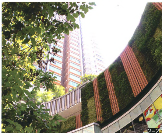
图1 纵向发展的香港城市形态 图2-1 沙田污水处理设施绿化屋顶 图2-2 新界荃新天地一期垂直绿化墙面 (引自香港高空绿化大奖, 2012年)
